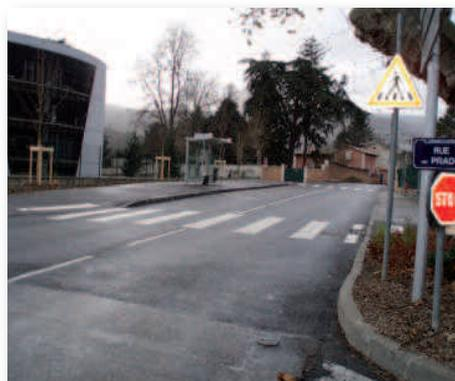
réalisation d'un trottoir en continu avec un muret de soutènement et un moyen d'accès à l'immeuble du Cardinal. L'abribus a été déplacé. La végétalisation s'est faite cet automne.
