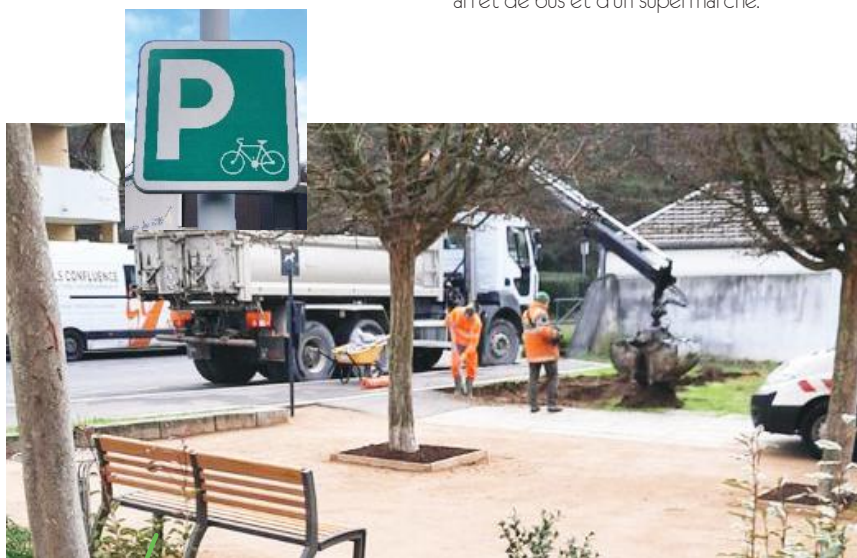
Travaux arceaux F Lacroix
