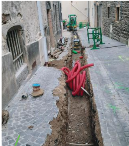
Travaux enfouissement rue Mardoré
